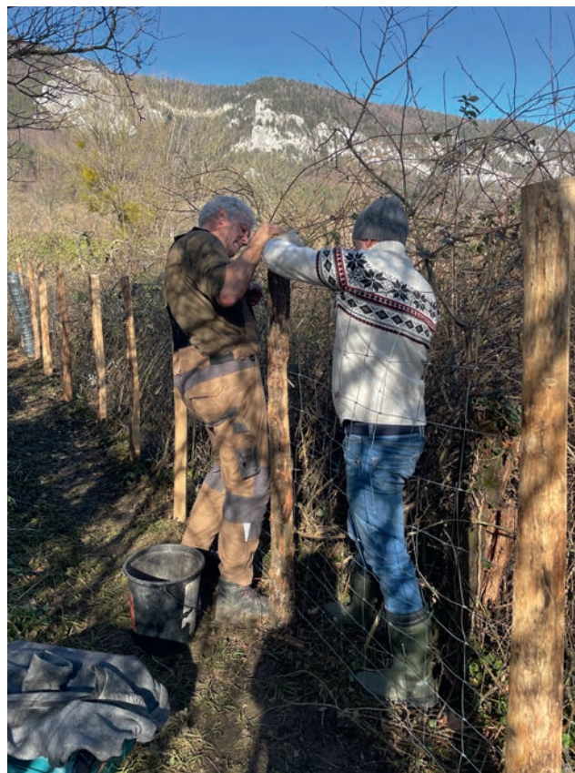
Jean-Daniel et Damien fixent un nouveau treillis. Les piquets en acacia sont réputés extrêmement solides, résistant bien aux insectes et à la pourriture. (voir aussi p.24)
