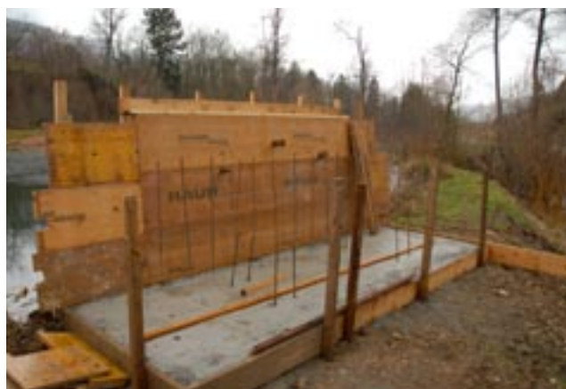
Coffrage mur avec préperçements
