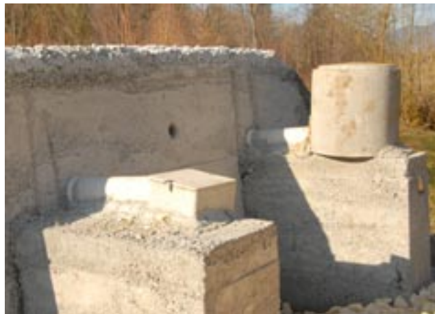
Pour favoriser la présence du Martin-pêcheur, une paroi artificielle a été construite au bord de l'étang Houriet (voir photo p. 8). Trois tunnels remplis de sable et qui aboutissent à une chambre pour le futur nid seront installés (photo prise derrière la paroi lors de sa construction en 2012).
